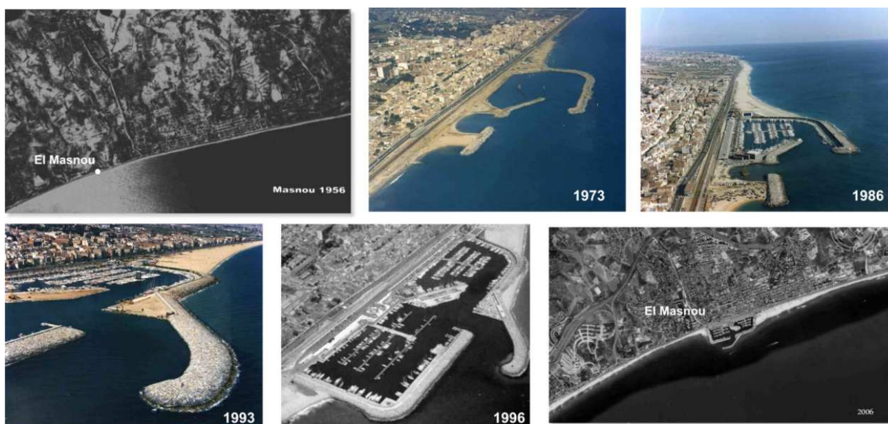
Figura 32. Les fotografies del port del Masnou mostren el problema d'acumulació de sorra des de la seva construcció, a començament dels anys setanta. Fotos cedides pels gestors del port del Masnou i la Generalitat de Catalunya.
