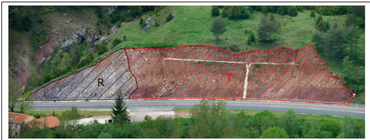
Fig. 8. División del talud por consistencia. R: área roca y T: área tierras
