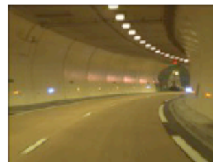
Source : DLPCA - Tunnel sur l'A50 (Toulon)
