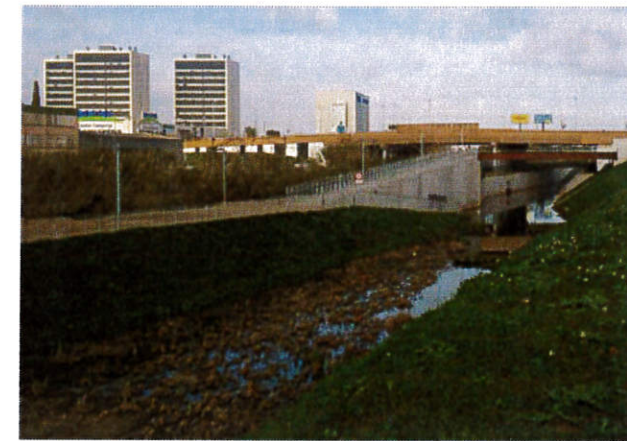
TALUDES RIERA DE SANT LLORENÇ
