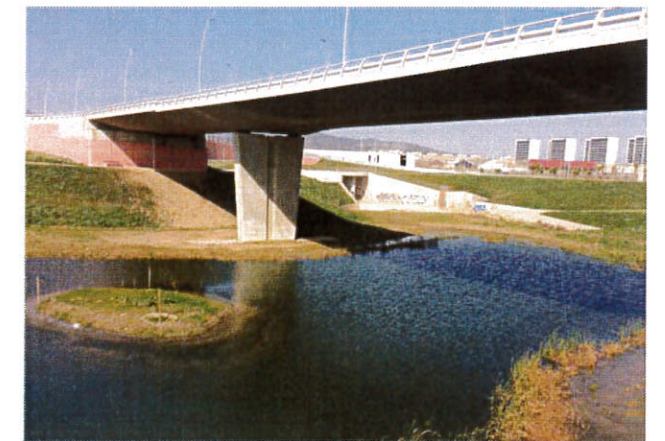
TALUDES Y FONDO Balsa DE LAMINACIÓN
